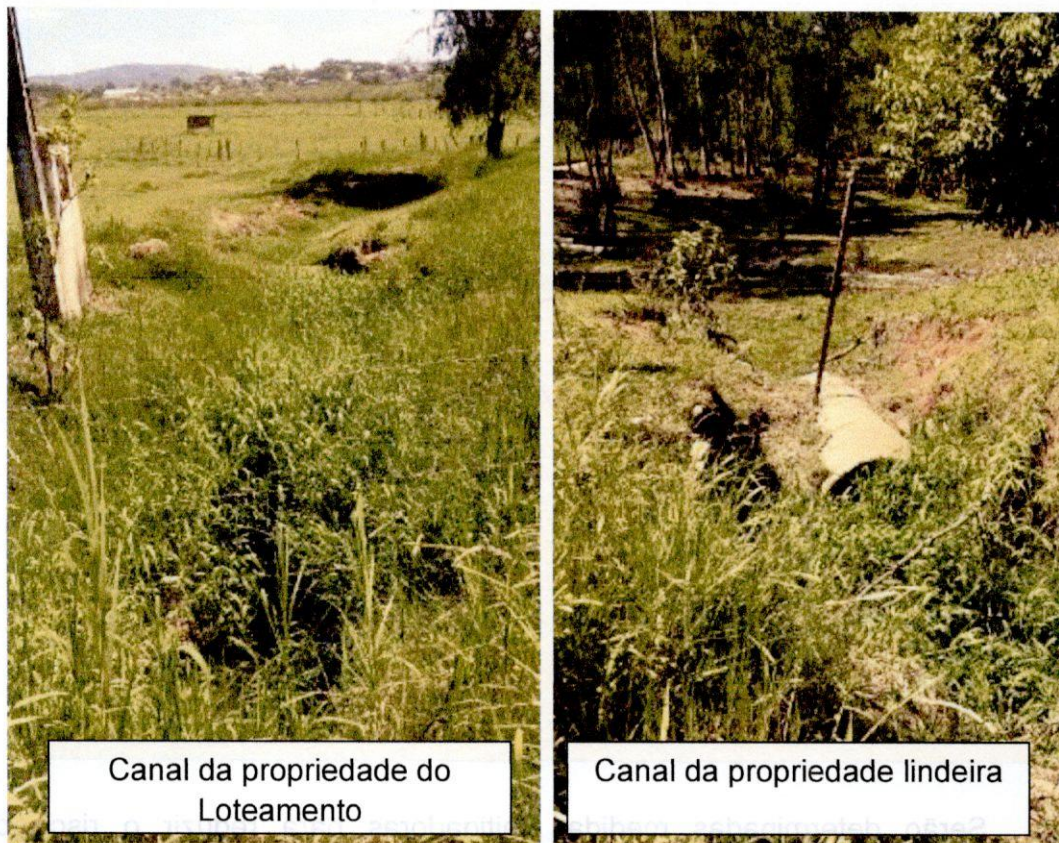
Figura 8: Canais de drenagem existentes
