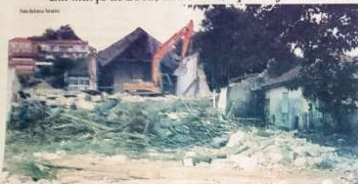
Em março de 2002, prédio acabou sendo demolido para abrigar supermercado
