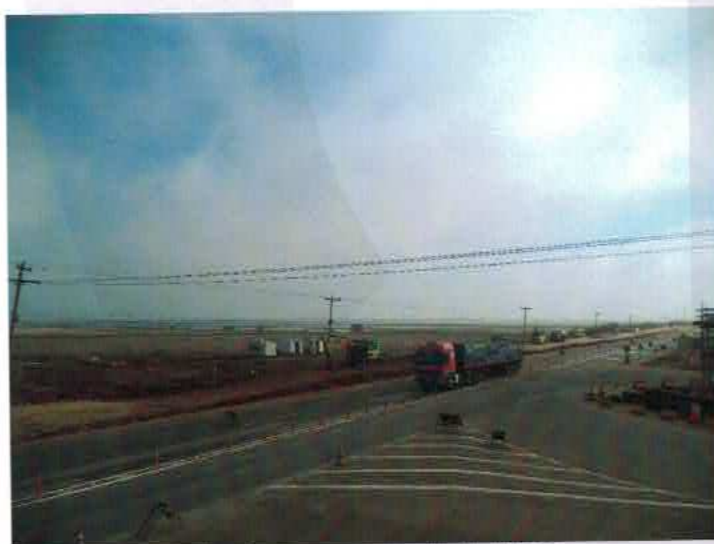
Balizadores para separação de tráfego
