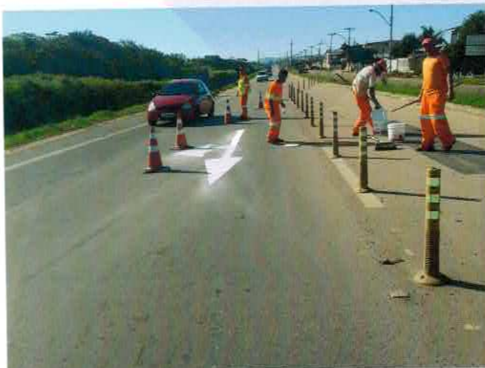
Equipe realizando manutenção da Sinalização
