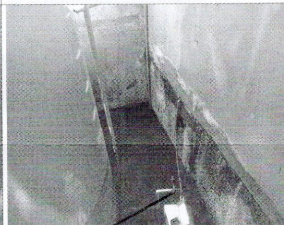
Figura 6 – Bacia de contenção do tanque de soda caustica.
